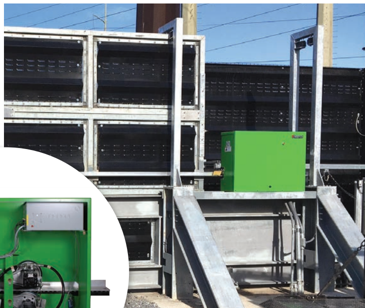
SlideDriver 200 opera una puerta contra impactos en la subcentral eléctrica
